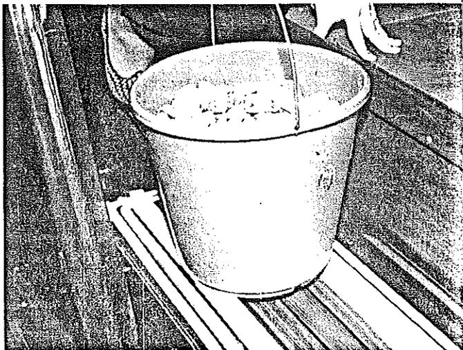
Der gesamte Innenboden muß 24 Stunden belastet werden. Dies kann mit Sandsäcken, gefüllten Wassereimern oder anderen Gewichten geschehen.
